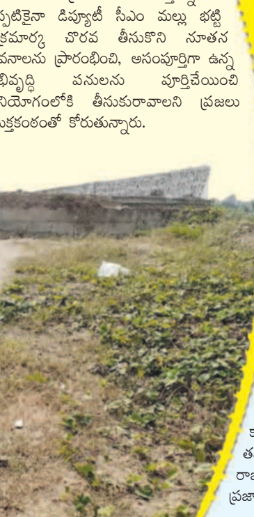
మధిర పట్టణంలోని లడకబజారులోని అయ్యప్పనగర్లో రూ.బదులక్షలతో ఎనిమిదేళ్ల క్రితం నిర్మించిన సబ్సెంటర్ నిరుపయోగంగా ఉంది. 2013లో మధిరలో రూ.25లక్షలతో స్త్రీ శక్తి భవనాన్ని నిర్మించారు. దాన్ని నేటికీ ప్రారంభించకపోవడంతో శిథిలావస్థకు చేరింది.
